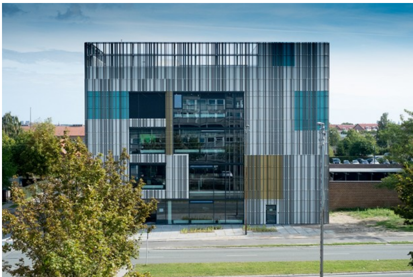
Vestegnen HF og VUCs nye undervisningsinstitution på Tårnvej er nomineret til titlen som 'Årets skolebyggeri 2016'. Foto: Brian Poulsen
